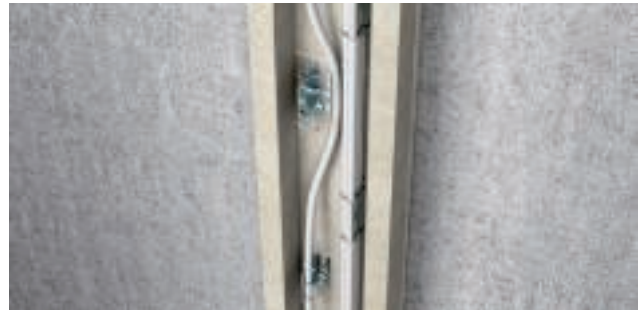
Verticale kabelinstallatie met leidinghouder
