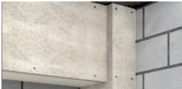
Wandaansluiting met wandaansluitmanchet
